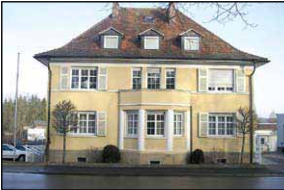
Konrad-Adenauer-Straße 20 in Ellwangen: Die Trainingswohnung befindet sich im Erdgeschoss
