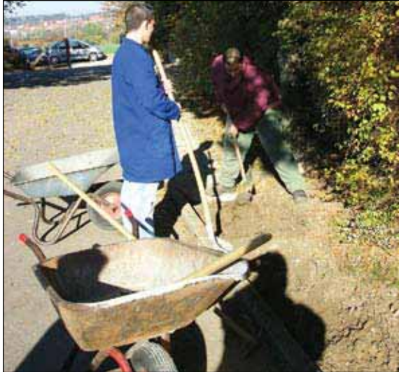
Mitarbeit bei Baumaßnahmen in der Schule
