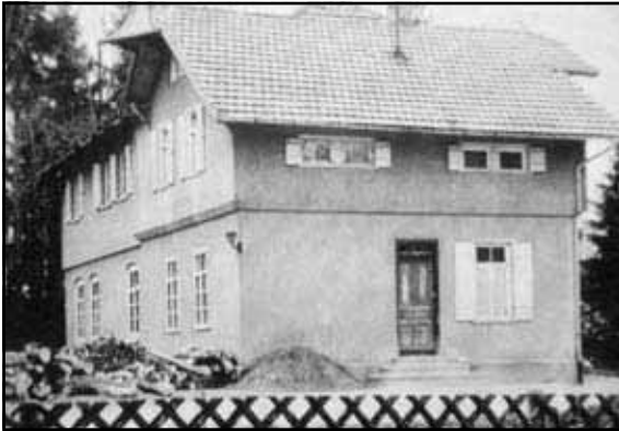
Das ehemalige Forsthaus in Aalen, Parkstraße 16, wird zum Schulhaus
