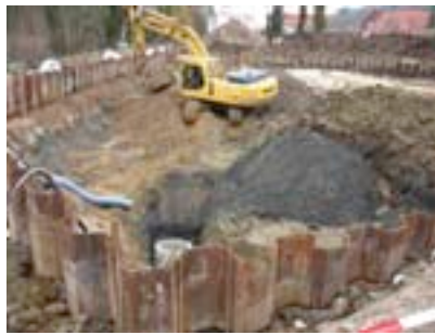
Lederfabrik Bopfingen: Aushub der Baugrube mit Spundwand (l.) und die Grundwasserreinigungsanlage (r.)
