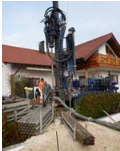
Bohrung auf engstem Raum
