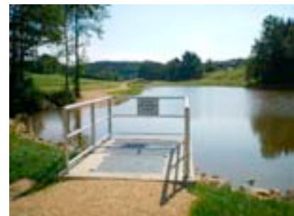
Fertiggestelltes Vorbecken im Sommer 2009
