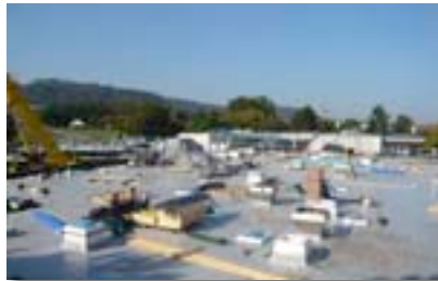
Das Dach der Jagsttalschule Westhausen während der Sanierungsarbeiten
