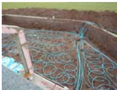
Kollektor oberflächennah verlegt
