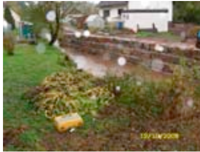
Dammverstärkung durch Blocksteinmauer am Sixenbach
