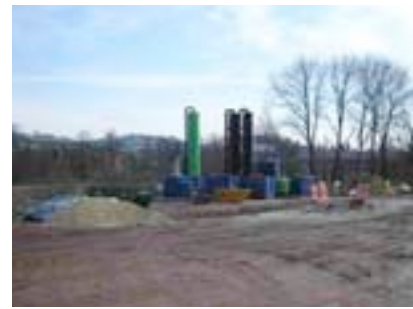
Lederfabrik Bopfingen: Aushub der Baugrube mit Spundwand (l.) und die Grundwasserreinigungsanlage (r.)
