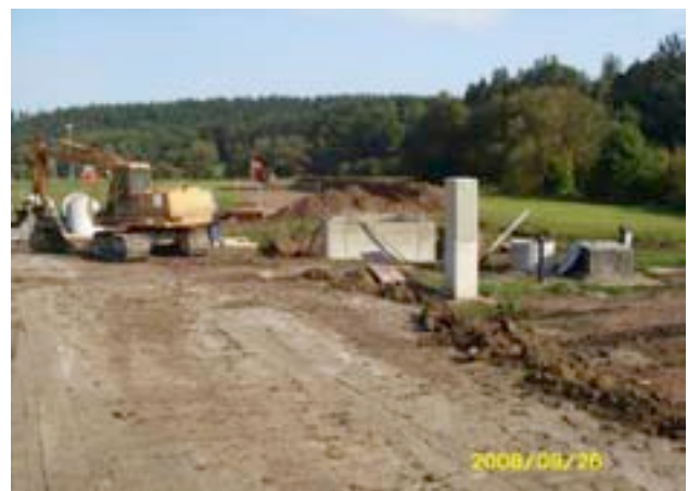
Bauarbeiten am Hochwasserschutzdamm
