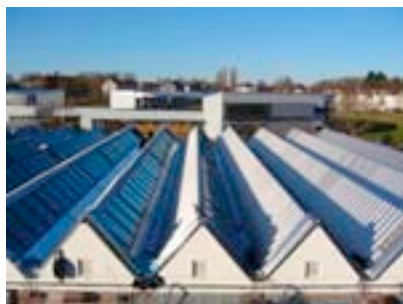
Sheddächer auf den Werkstätten des Kreisberufsschulzentrums Schwäbisch Gmünd
