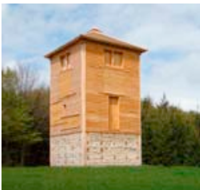
Der neu aufgebaute Limesturm in Rainau-Buch
