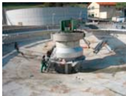
Sammelkläranlage Oberkochen, Montagearbeiten im Nachklärbecken
