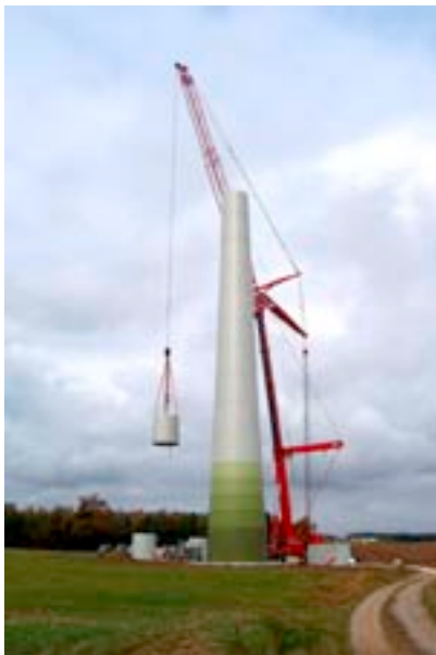
Aufbau der Windkraftanlage bei Ruppertshofen
