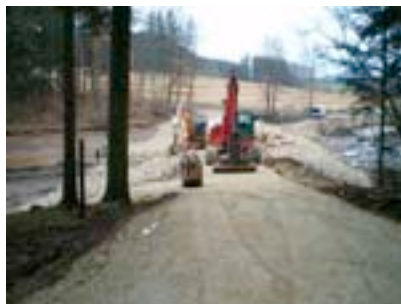
Dambbauarbeiten am Vorbeckendamm
