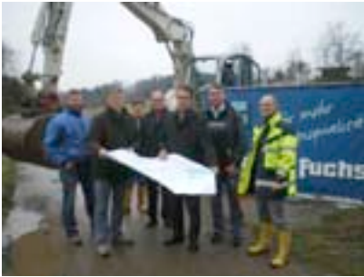
Spatenstich zur Hochwasserschutzmaßnahme Ellwangen
