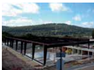
Mehrweckhalle Lorch im Rohbau
