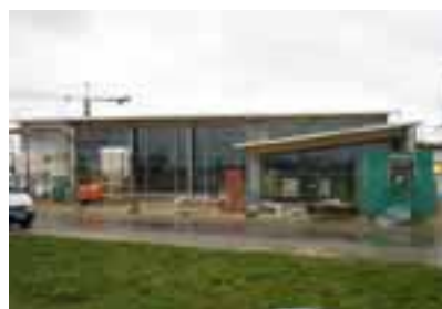
Mehrweckhalle Ruppertshofen im Rohbau
