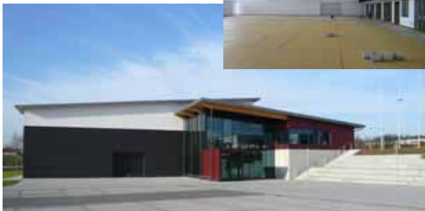
Mehrweckhalle in Gschwend mit noch im Bau befindlicher Innenansicht
