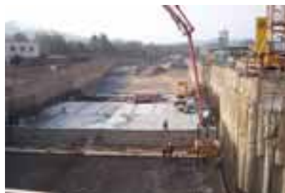
Großbaustelle in Schwäbisch Gmünd
