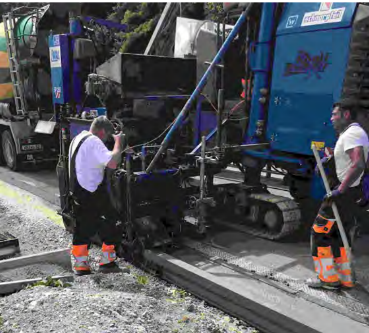
B29 Lorch – Schwäbisch Gmünd, Gleitschalungsfertiger für Bordrinne
