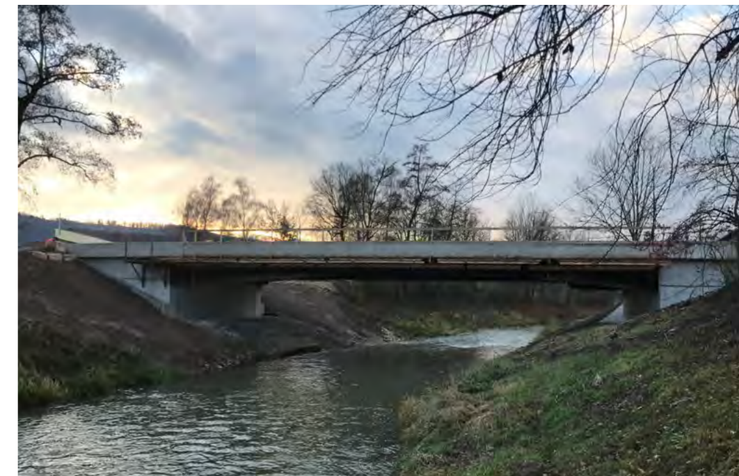
K 3272 Neubau der Remsbrücke in Waldhausen
