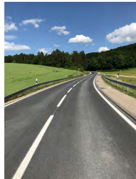
Belagssanierung K 3301 Neresheim – Maria Buch
