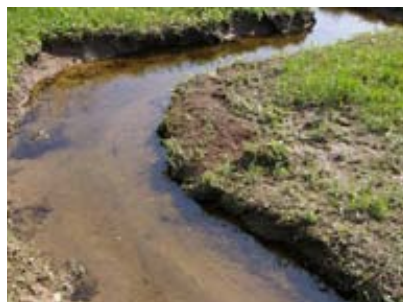
Aufgrund des rechteckig gegrabenen Kastenprofils mit senkrechten Wänden entwickelt sich das neue Bachbett von alleine. Durch den winterlichen Frostwechsel und die Wasserströmung hat sich bereits in kurzer Zeit ein natürliches Bachprofil entwickelt. Auf teure und nur bedingt naturnahe Modellierungen wurde daher bewusst weitgehend verzichtet
