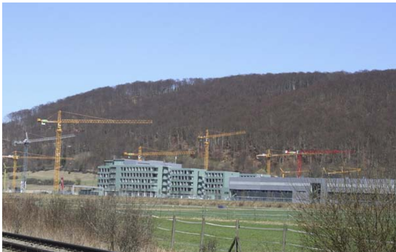
Die Baustelle der Carl-Zeiss SMT zwischen Oberkochen und Königsbronn
