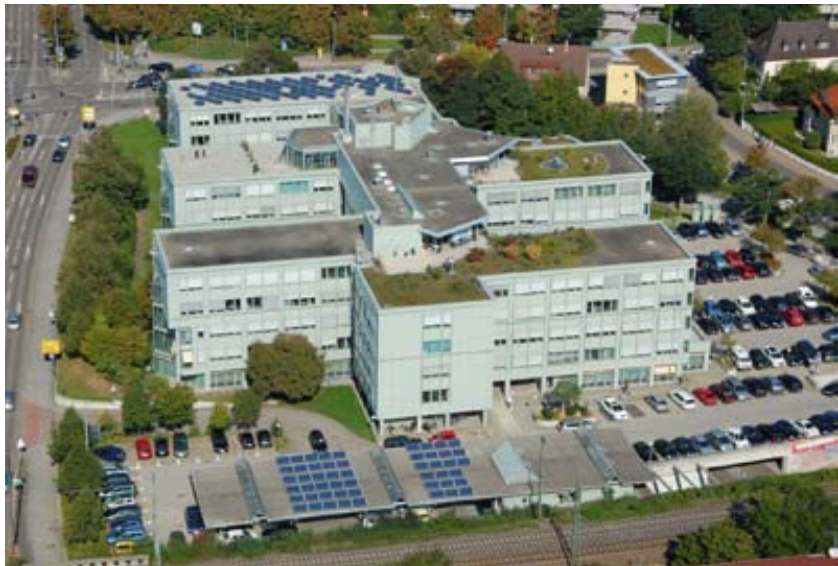
Im Bildvordergrund ist die erste landkreiseigene Photovoltaikanlage auf der Parkplatzüberdachung zu sehen. Auf dem Gebäudedach die Photovoltaikgemeinschaftsanlage von insgesamt 15 Beschäftigten der Landkreisverwaltung, die bereits im Jahr 2009 installiert wurde
