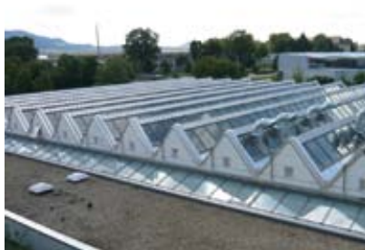
Die sanierten Sheddächer des Werkstattbereiches am Beruflichen Schulzentrum Schwäbisch Gmünd
