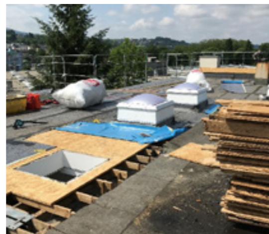
Rückbau Dach + Einbau neue Lichtkuppeln
