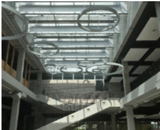
Neue Beleuchtung Aula
