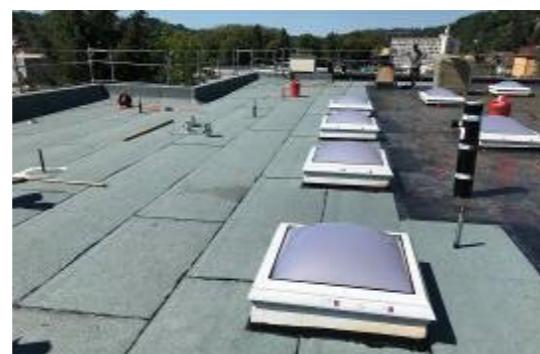
Einbau neuer Abdichtungsbahnen
