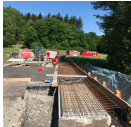
K 3233 Sanierung Blinde Rot Brücke bei der Burghardsmühle
