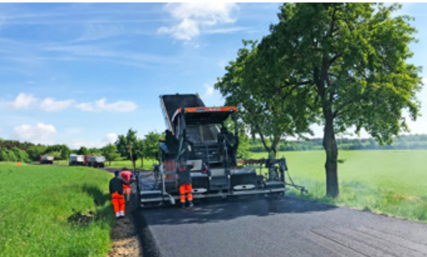
Belagssanierung K 3314 Schweindorf - B 466
