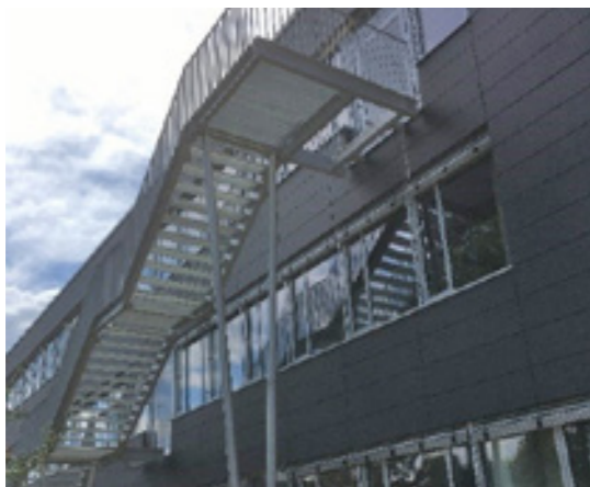
Neue Fluchttreppe Ostseite
