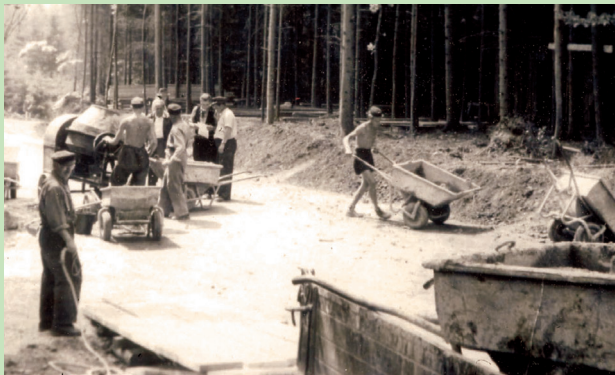
Bunkerbau im Staatswald, Baubeginn ca. 1954.
