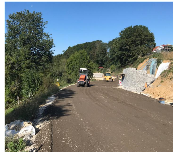
K 3253 Einbau der hydraulisch gebundenen Tragschicht aus Recyclingmaterial der alten Fahrbahnbefestigung und Bau von Gabionen zur Böschungssicherung
