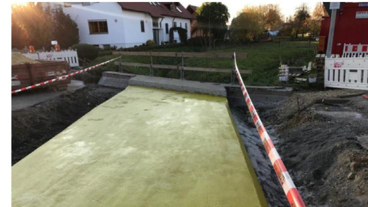
K 3304 Sanierung der Brühlgrabenbrücke in Benzenzimmern, Erneuerung der Abdichtung
