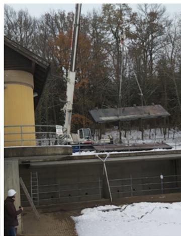
Die Fotos zeigen das Abfischen, den Beginn der Entlandungsarbeiten sowie den Ausbau der Fischbauchklappe der Hochwasserentlastung.
